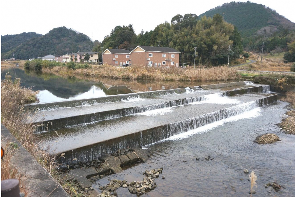
落差工（らくさこう）（松江市八雲町。八雲中学校前）
