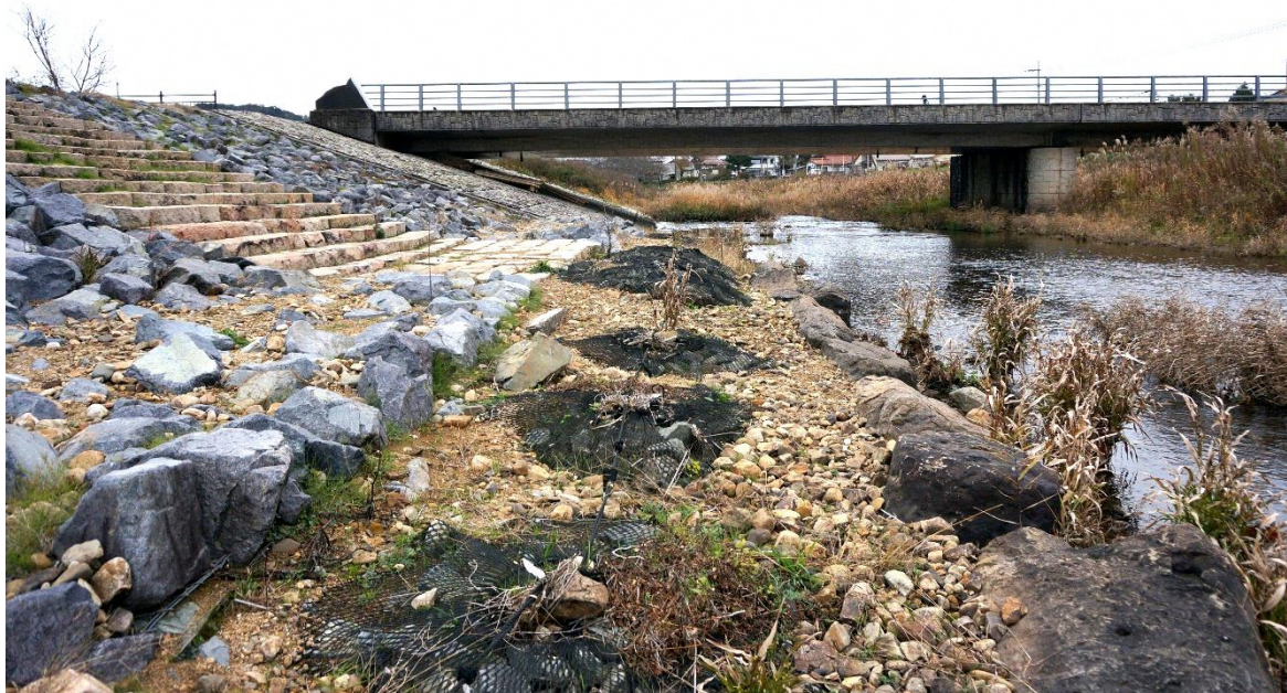
石積護岸（松江市八雲町。八雲中学校前）
