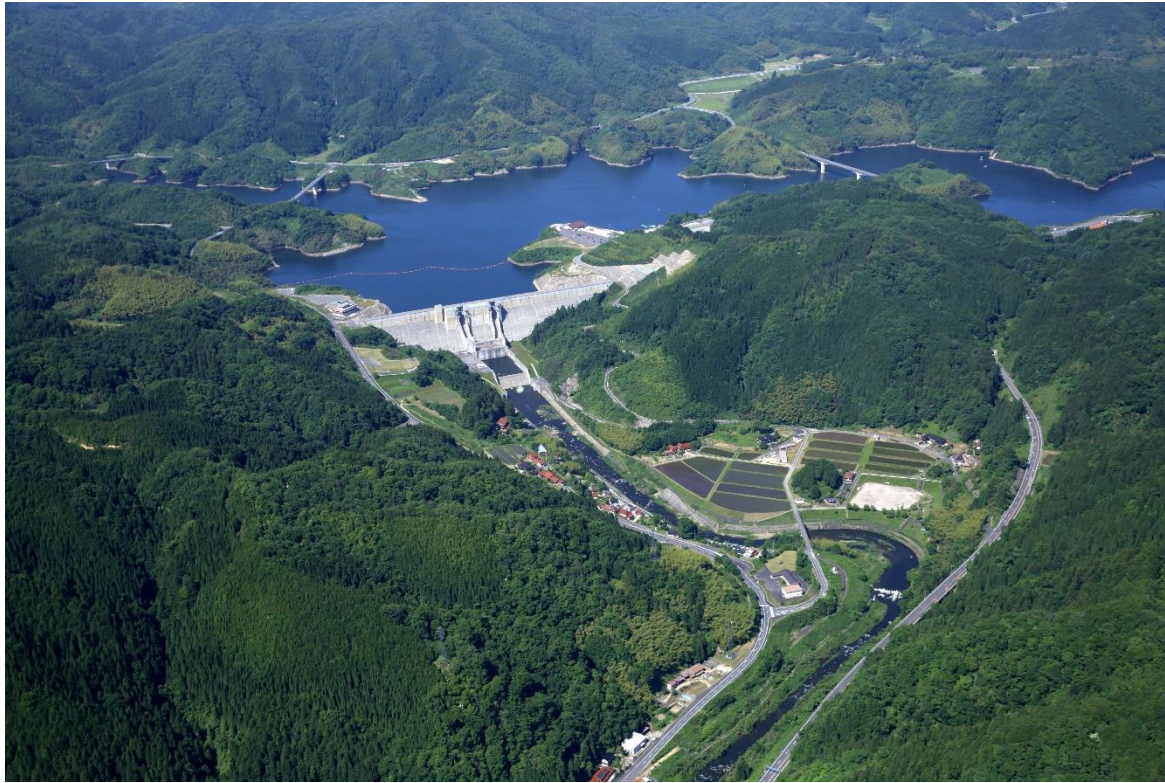
尾原ダム（雲南市木次町）（国土交通省 出雲河川事務所 提供）
