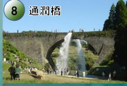
水不足に悩む台地を救うため嘉永7年(1854年)に完成した水道橋。日本最古の現役水道橋であるこの石橋は、火砕流によって生じた阿蘇溶結凝灰岩でつくられています。
