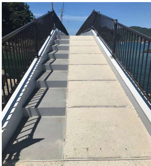
改修された神崎橋
