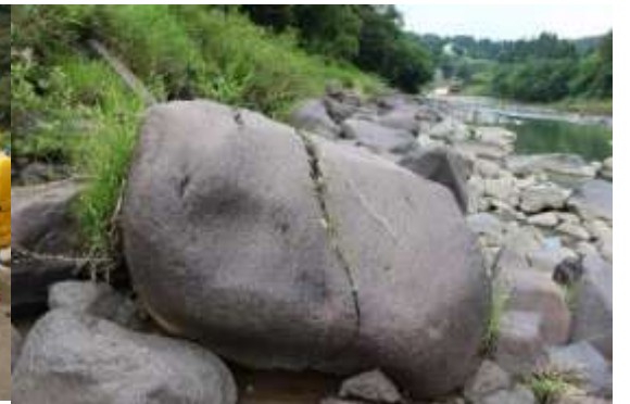
県境(宮野原橋下)のくさび石
